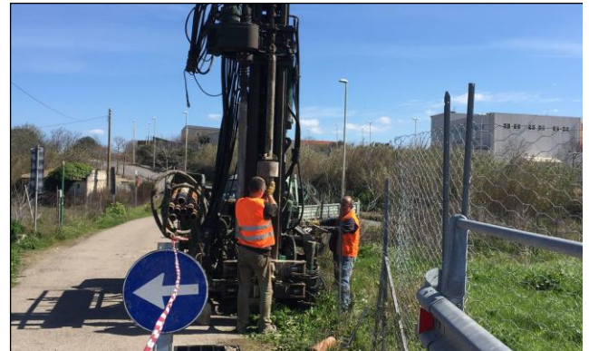
Figura 5 Approntamento dell'attrezzatura per l'esecuzione della prova SPT.
