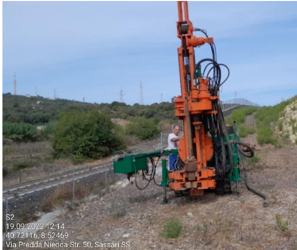
Figura 4. Indagini geognostiche: a sinistra, esecuzione del sondaggio S2; a destra, esecuzione del pozzetto P1.
